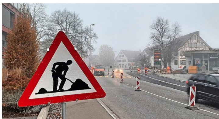
Die Baltenswilerstrasse im Zentrum von Bassersdorf wird derzeit komplett erneuert und umgestaltet. Archibild: Christian Wüthrich
